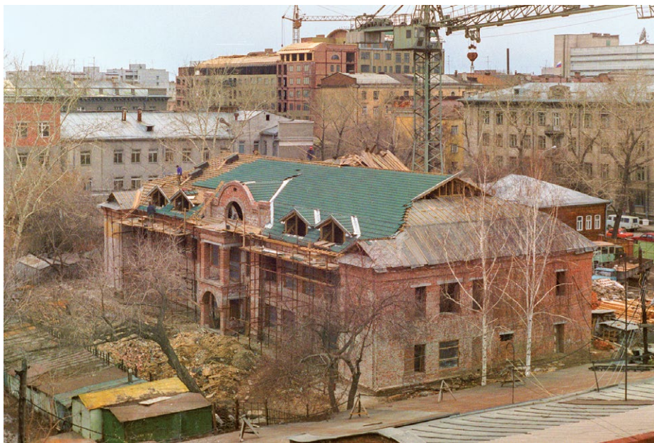
Строящийся Музей Н.К. Рериха в Новосибирске. 2000
