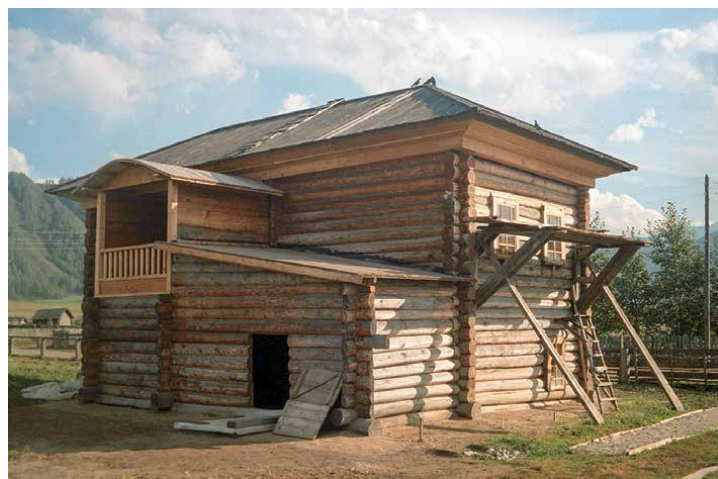
Завершение восстановительных работ
