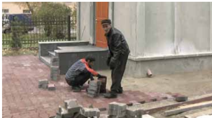
Укладка тротуарной плитки
