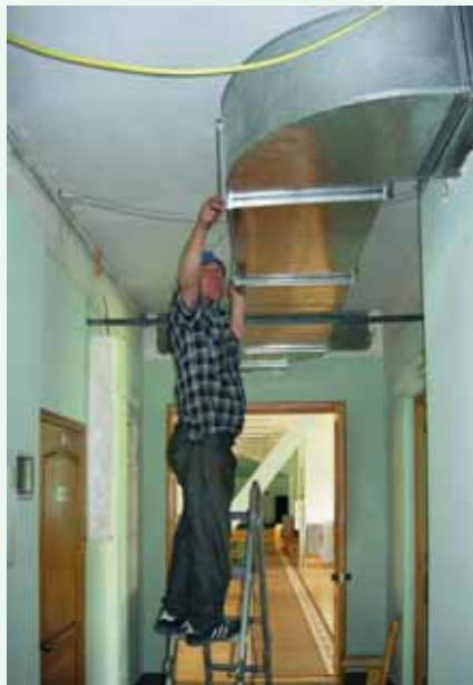
Монтаж вентиляции на третьем этаже Музея. Сентябрь 2005 г.
