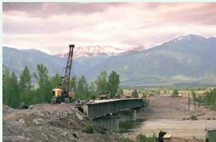
Мост через Катунь
