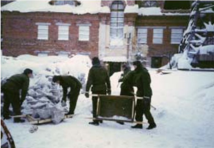
Военнослужащие на строительстве Музея Н.К.Рериха. 1998
