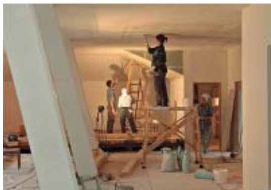
Отделочные работы на мансарде
