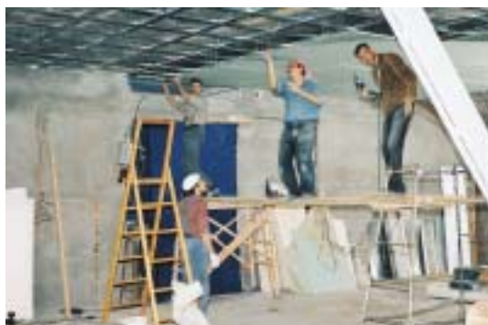
Монтажные работы на мансарде. Май 2004
