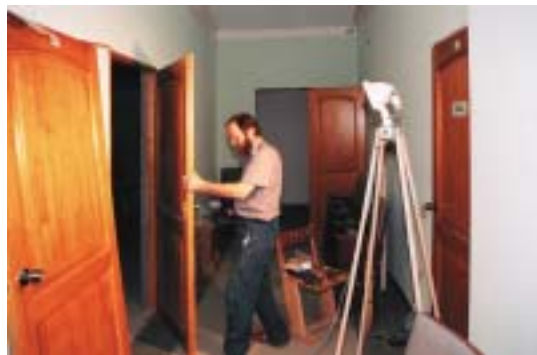
Установка дверей на 3-м этаже Музея
