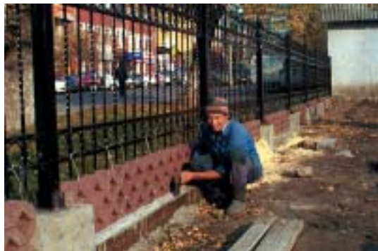
Монтаж цоколя ограждения Музея Н.К.Рериха
