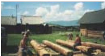
Подготовка брёвен сруба
