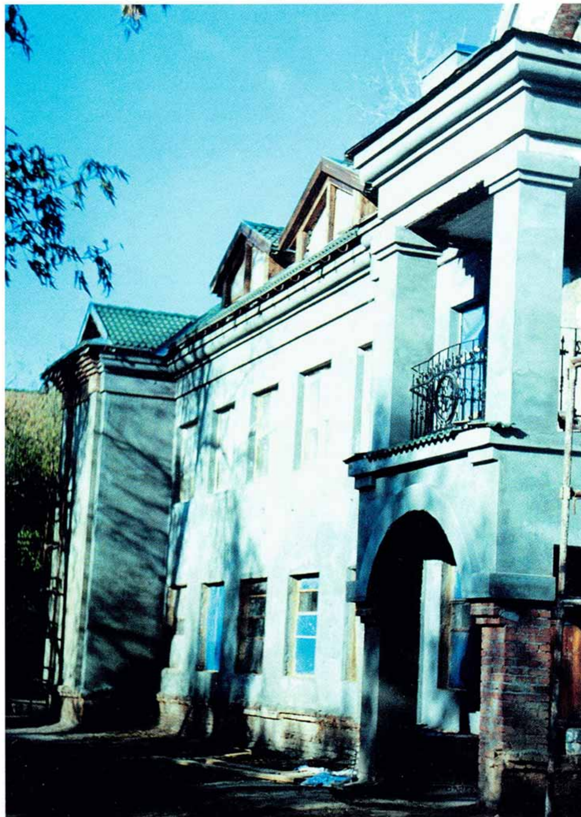
Музей им.Н.К.Рерих в Новосибирске, октябрь 2000 Начаты работы по отделке фасада
