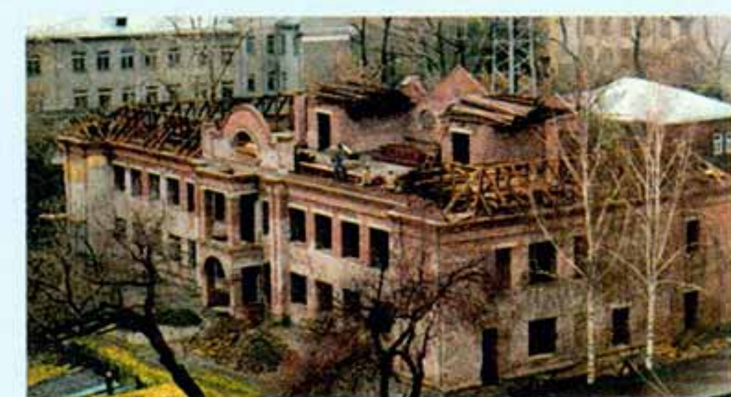
Строительство Музея Н.К.Рериха. Новосибирск
