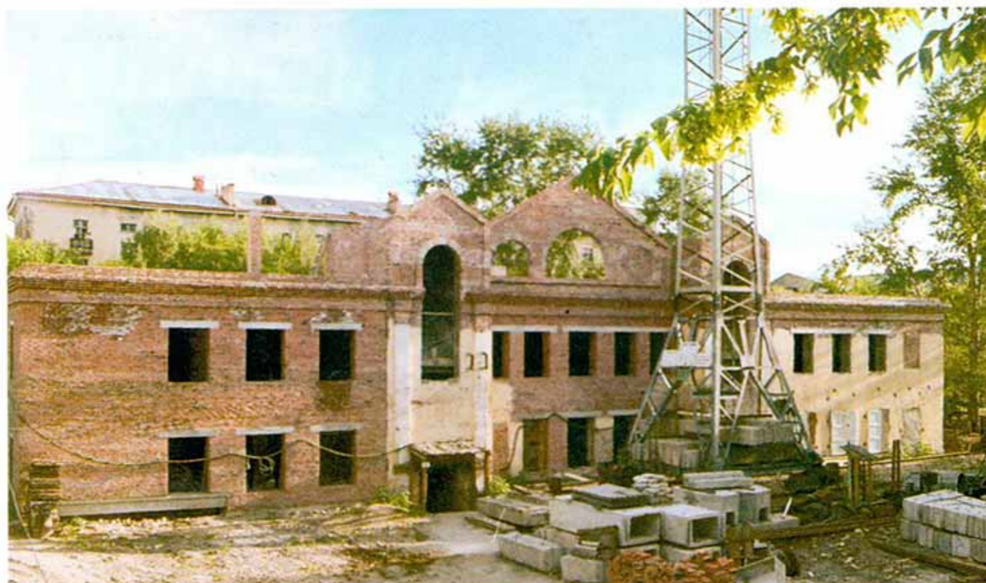
Строительство Музея Н.К.Рериха в Новосибирске. Сентябрь 1998 г.
